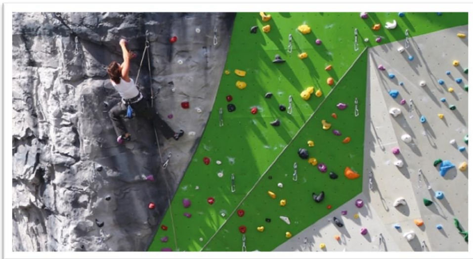
Slika 37 Zanimiva kombinacija lesenih in plastičnih plezalnih plošč na eni plezalni steni (Walltopia, 2011)
