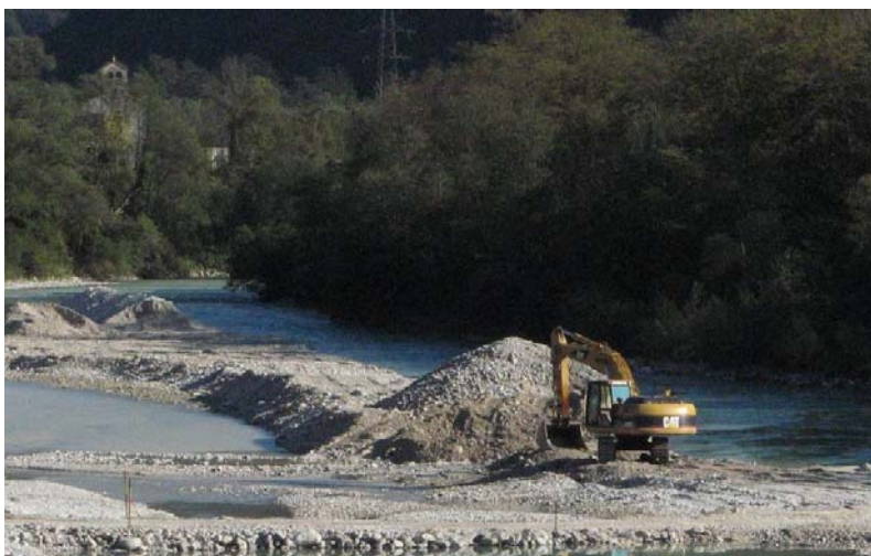
Slika 6: Črpanje gramozu na Soči (pod mostom čez Sočo pri Tolminu)
