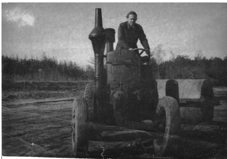
Slika 29: Začetki gradnje nogometnega igrišča
