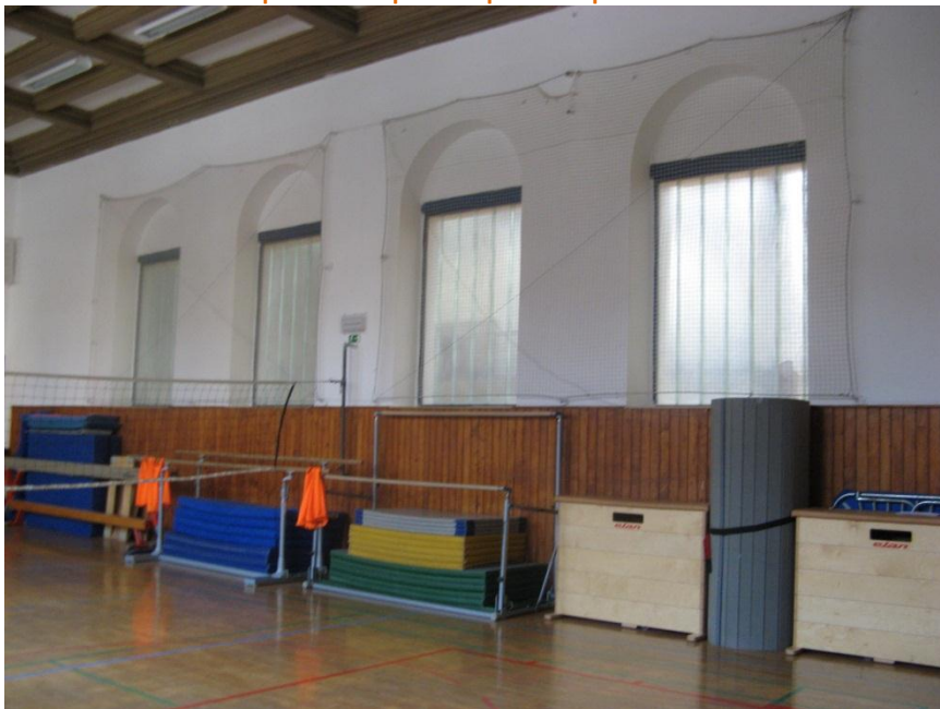
Slika 4. Primer nevarne postavitve športne opreme v športni dvorani
