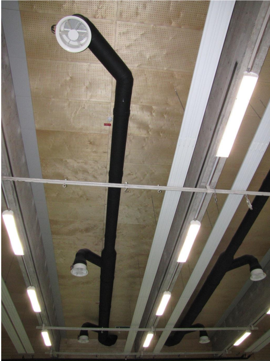
Slika 3: Sodoben sistem prezračevanja z vračanjem toplote odpadnega zraka
