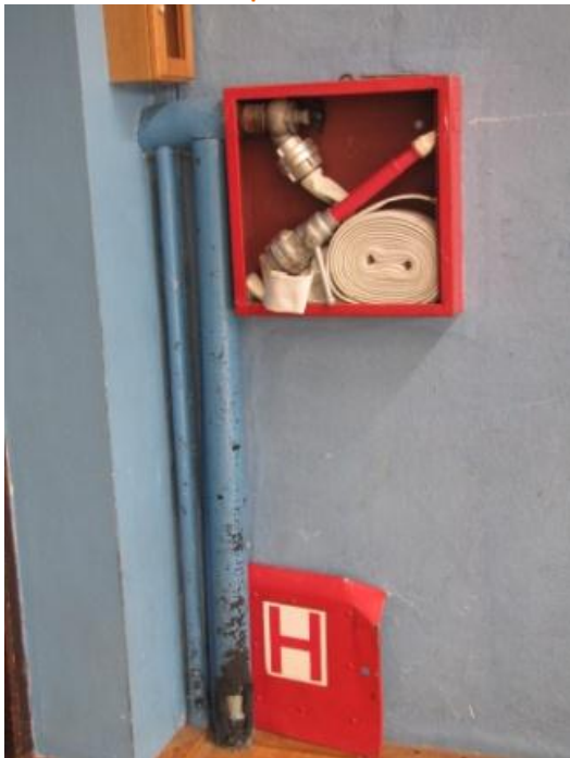
Slika 3. Nezaščiten in poškodovan hidrantna omarica v športni dvorani
