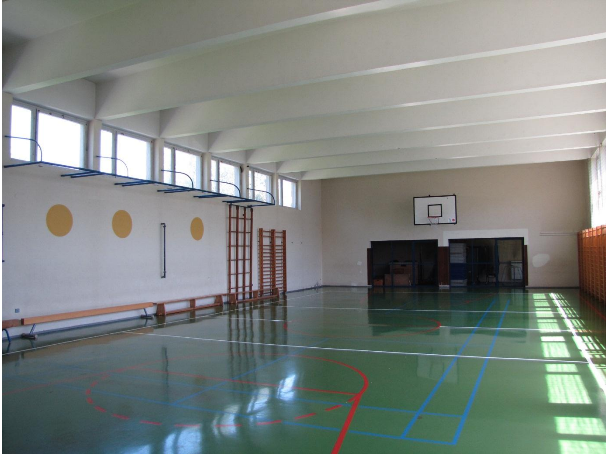
Slika 1: Poliuretanski športni pod v eni od tipičnih starih športnih dvoran v Sloveniji
