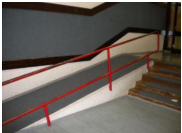
Slika 2: Primer neustreznega premagovanja višinske razlike pri vstopu v športno dvorano za gibalno oviranega učenca in primer ustrezne rešitve
