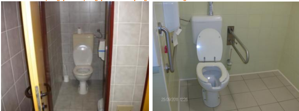
Slika 4: Primer neprilagojenih in prilagojenih sanitarij za gibalno oviranega učenca
