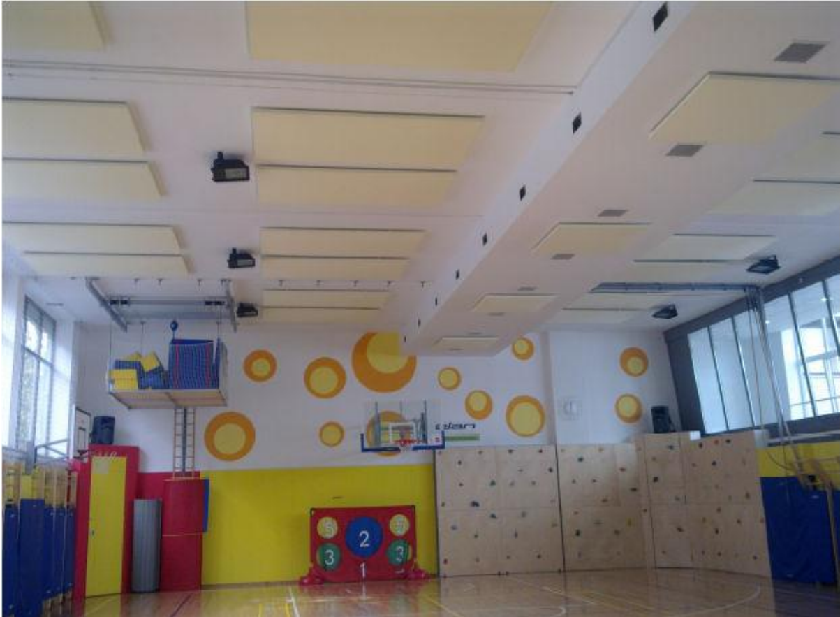
Slika 1: Vgradnja akustičnih jader v športni dvorani Škrlatica
