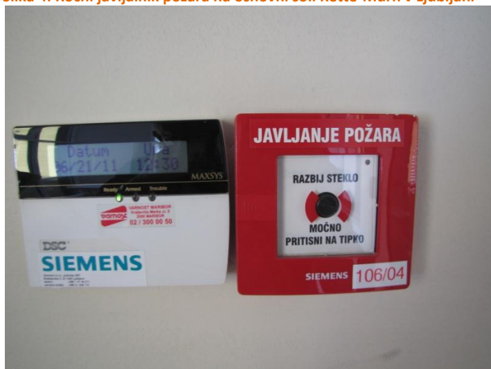
Slika 4: Ročni javljalnik požara na osnovni šoli Kette-Murn v Ljubljani
