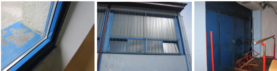
Slika 3: Okna in vrata športne dvorane
