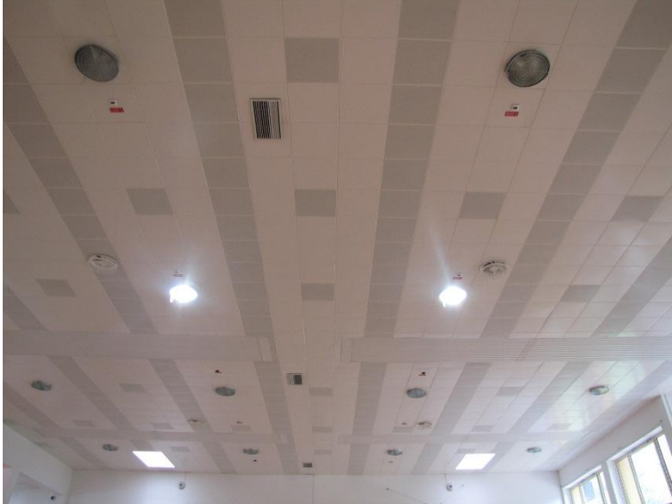
Slika 5: Primer enakomerne razporeditve sijalk po stropu
