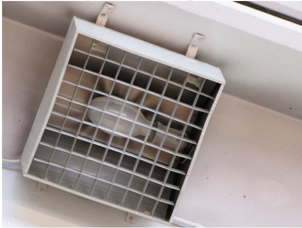
Slika 4: Zaščita sijake: varnostna ohišja svetilk in nosilci zanje
