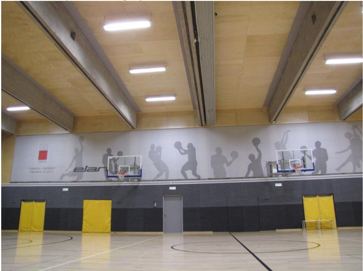
Slika 2: Akustične stropne in stenske obloge v športni dvorani Krn
