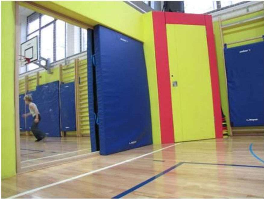
Slika 6. Primeri umestitve in zaščite stekla v športni dvorani
