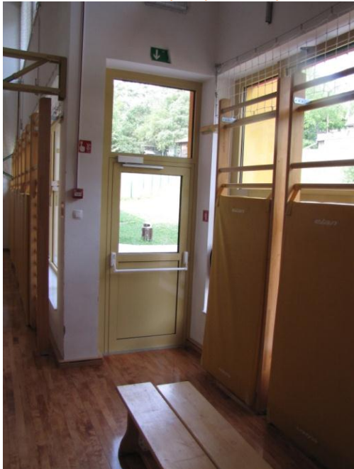
Slika 1: Požarna vrata s protipanično kljuko in samozapiralom na osnovni šoli Mojstrana
