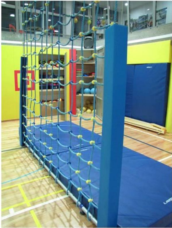
Slika 22: Zaščita jeklenice pri viseči mreži, ki se spušča iz stropnega nosilca, zadaj izkoristek kota telovadnice (kotna omara) in stenske niše
