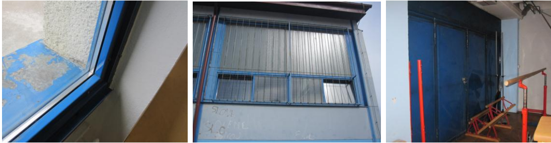
Slika 31: Okna in vrata športne dvorane
