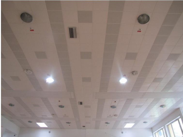
Slika 28: Primer enakomerne razporeditve sijalk po stropu
