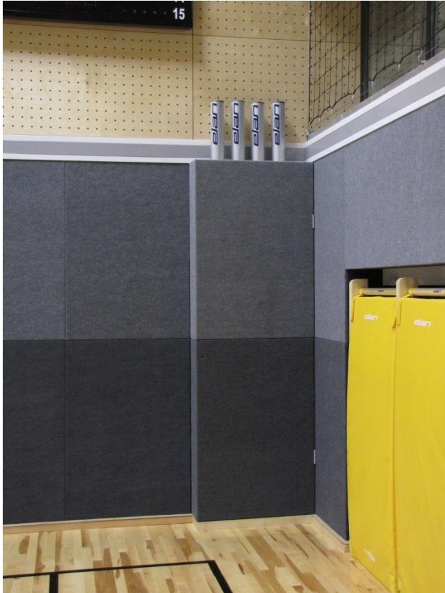
Slika. Primer mehke zaščite sten in umestitve skladišča za odbojbarske stebre ob steno
