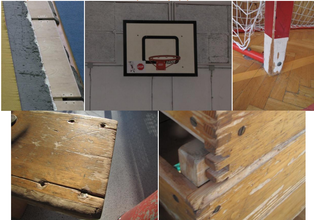
Slika 1: Primeri poškodovanih in/ali nevdrževanih naprav, orodij in pripomočkov
