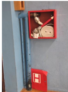
b) zvita in odlomljena vrata hidranta v dvorani
