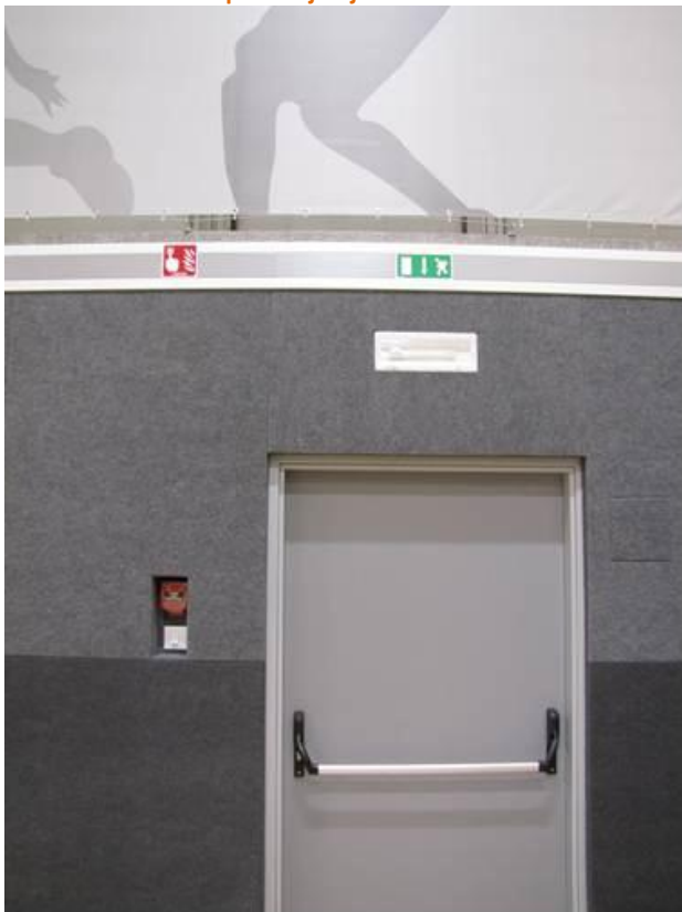
Slika 5: Prostor za oznake, umestitev javljalnika požara na steni in požarna vrata s protipanično kljuko v športni dvorani Krn na Fakulteti za šport v Ljubljani
