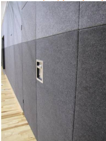
Slika. Primeri potopljivih kljuk in potopljivih vijakov na steni športne dvorane
