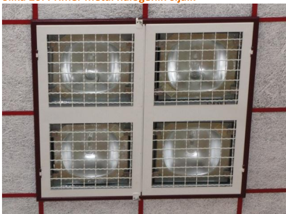
Slika 26: Primer metal halogenih sijalk
