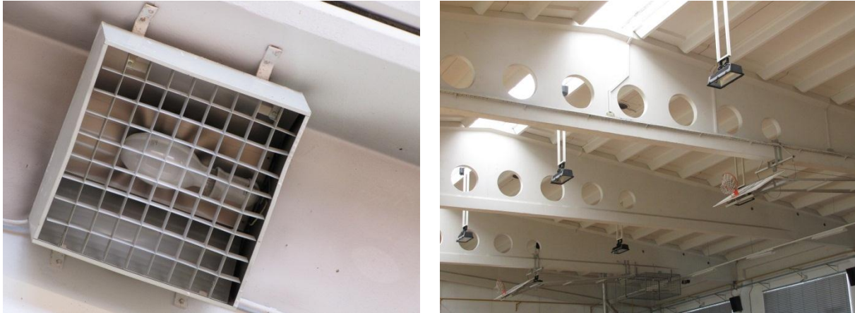
Slika 24: Zaščita sijake: varnostna ohišja svetilk in nosilci zanje
