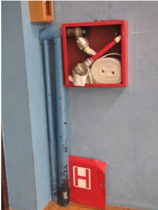
Prikaz 5. Zvita in odlomljena vrata hidranta v dvorani
