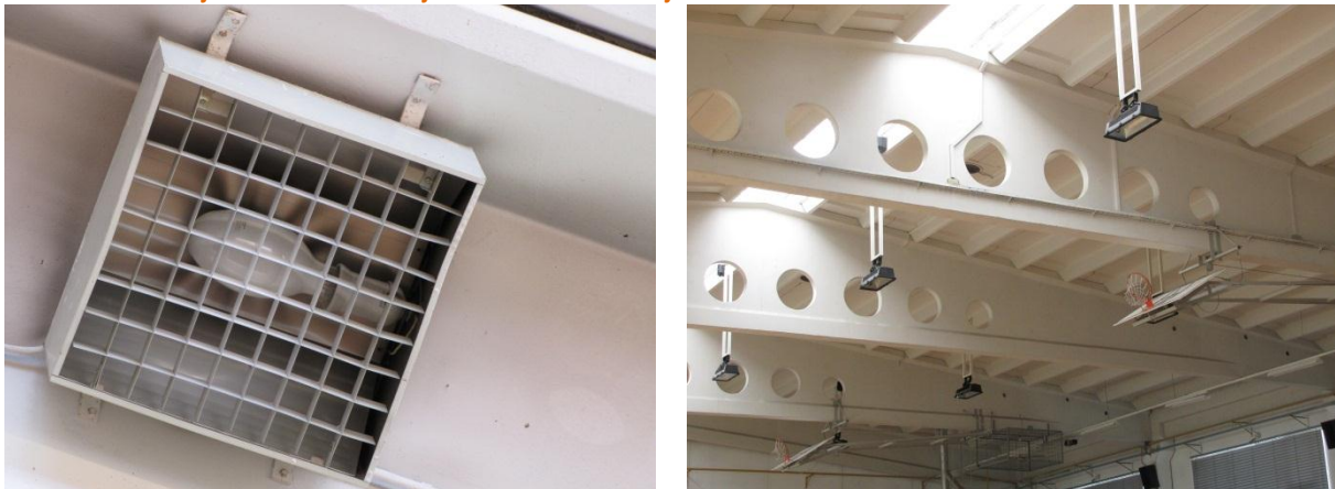
Slika 27: Zaščita sijake: varnostna ohišja svetilk in nosilci zanje
