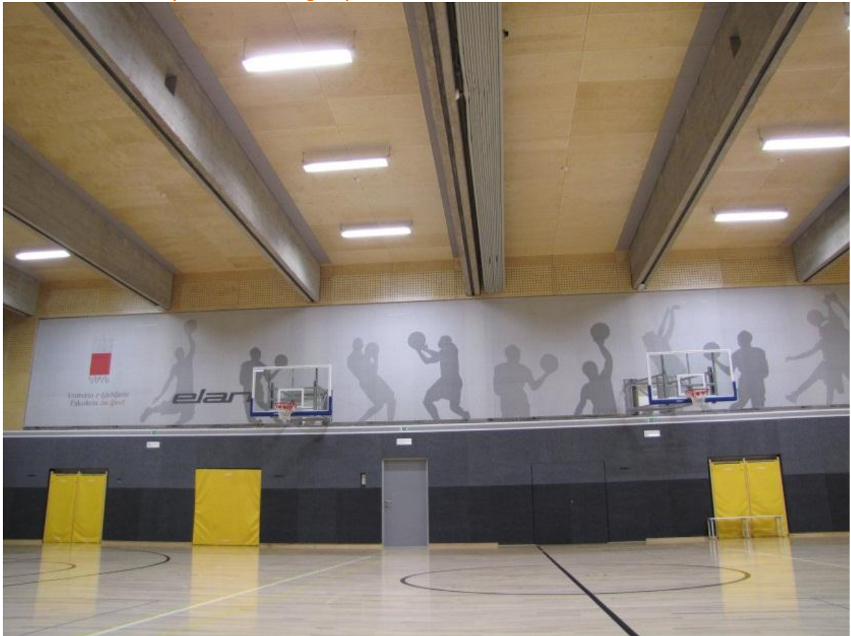
Prikaz 64: Akustične stropne in stenske obloge v športni dvorani Krn
