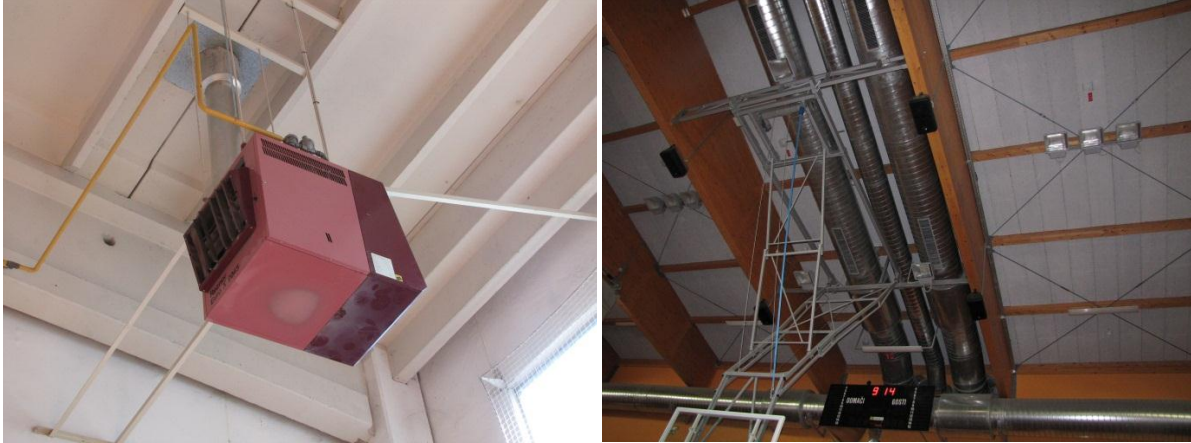
Prikaz 49: Toplozračno ogrevanje športne dvorane (kalerifer v dvorani, dovod toplega zraka v dvorano)
