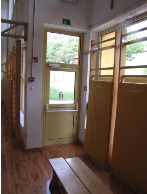
Slika 27: Požarna vrata s protipanično kljuko in samozapiralom na osnovni šoli Mojstrana
