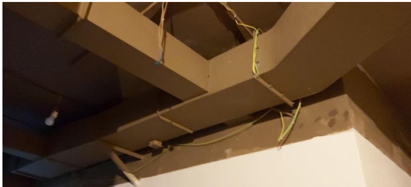
Slika 40: Uničen/odprt strop v garderobi
