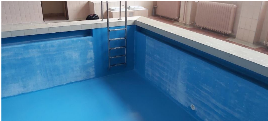
Slika 43: Bazenska školjka samo delno prebarvana
