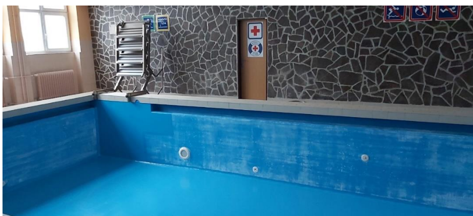
Slika 44: Bazenska školjka samo delno prebarvana
