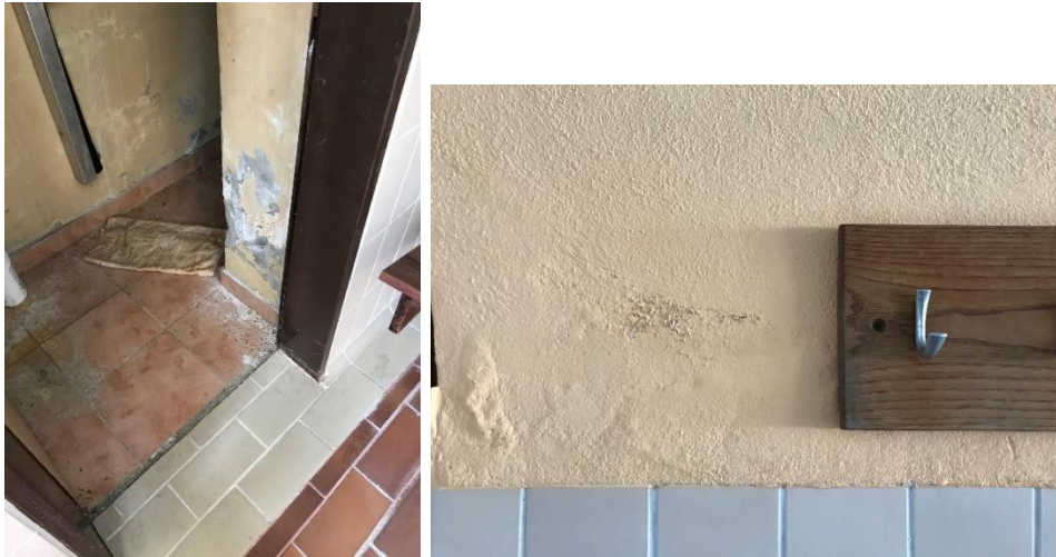
Slika 42: Uničen obbазenski prostor in luščenje stene
