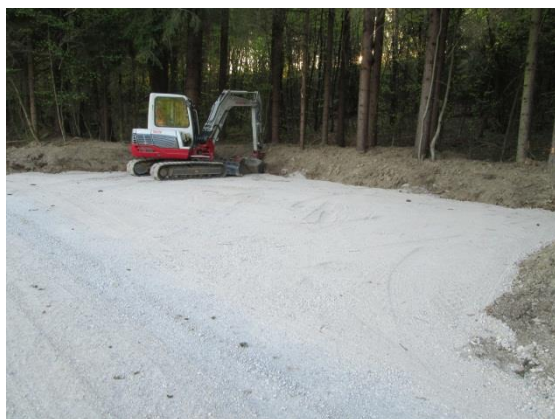
Slika 66. Zemeljska dela na trim stezi (osebni arhiv).
