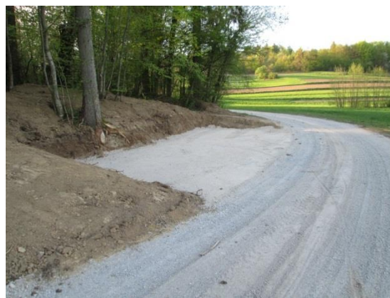
Slika 67. Zemeljska dela na trim stezi (osebni arhiv).
