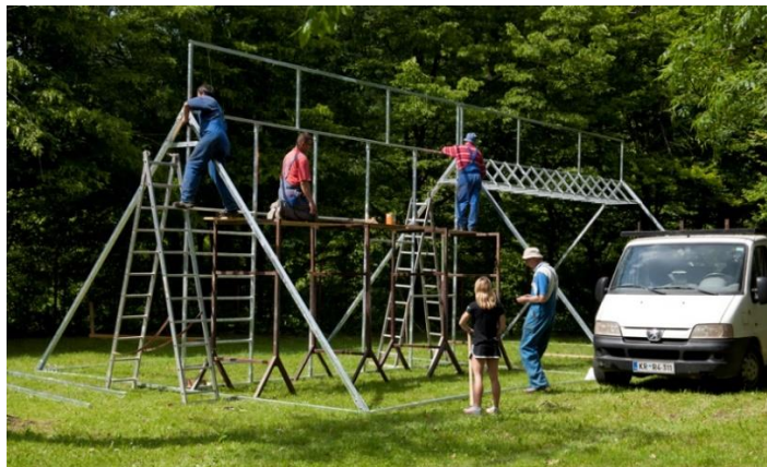
Slika 19. Postavitev montažne jeklene konstrukcije.
