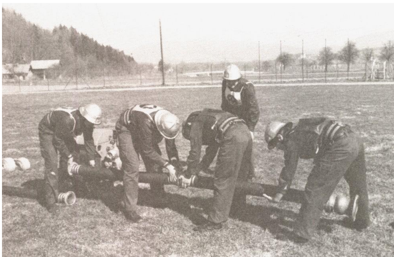
Slika 8. Spajanje sesalnih cevi (Lešnik, 2003).
